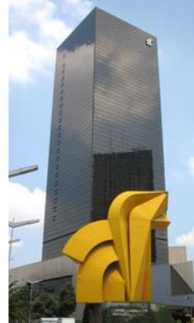
Torre Caballito Reforma Corridor
